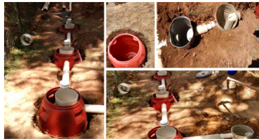
Figura 3. Execução do protótipo da FossaWet
