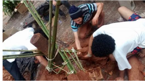
Fig. 12 Construção de uma lareira no Bosque
