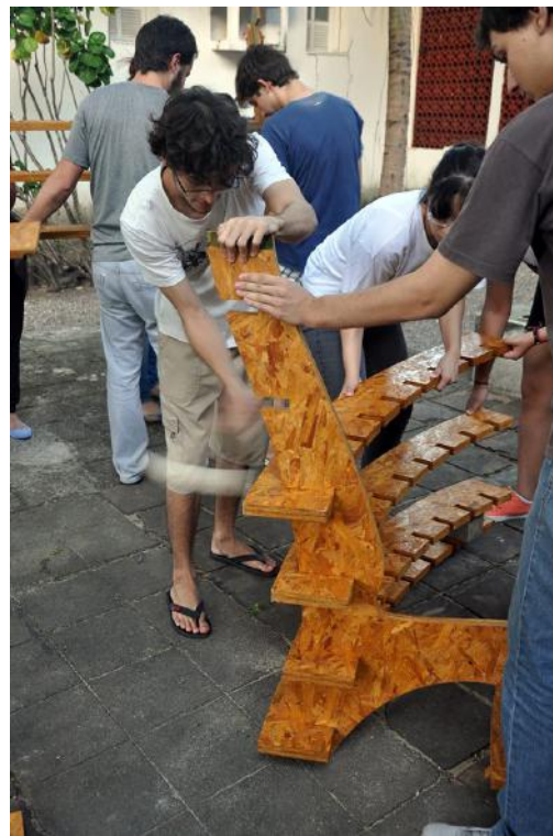
Figura 10: Posicionamento inicial de todos os perfis horizontais.
